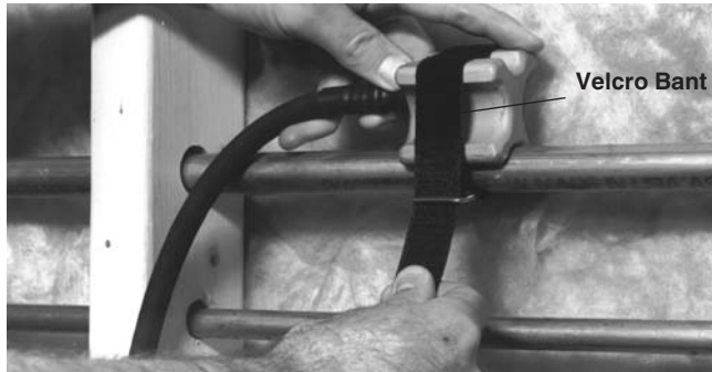
Şekil 5 – Dondurma Kafasının Velcro Bantla Uygulanması
