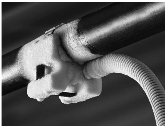
Рис. 9 – Примерзшая к трубе замораживающая головка
