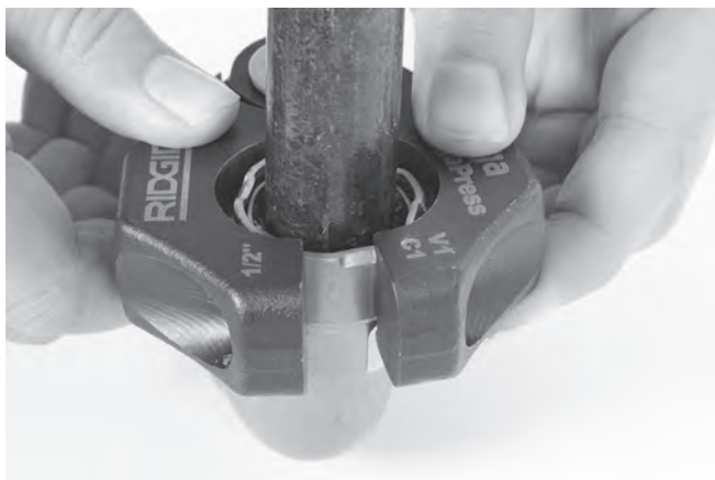
Figur 11 – Påsætning af pressering på fitting
